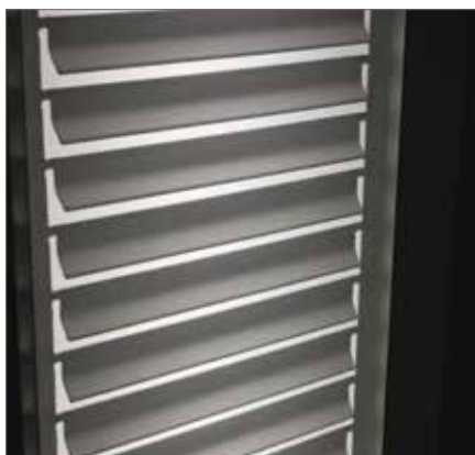
Particolare del louver Louver detail
